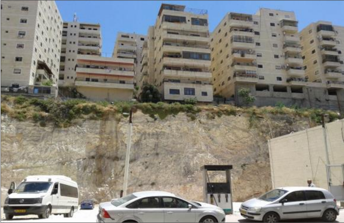
صورة رقم (4): توضح منطقة بناء خطيرة على جبل رأس شحادة
